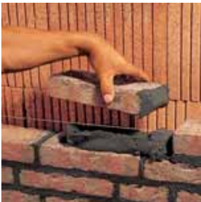
1. Укладка камня на высокопластичном кладочном растворе V.O.R. с полной заливкой швов, выпускаемом фирмой "Квик-микс". Прочное сцепление раствора с кирпичом.
